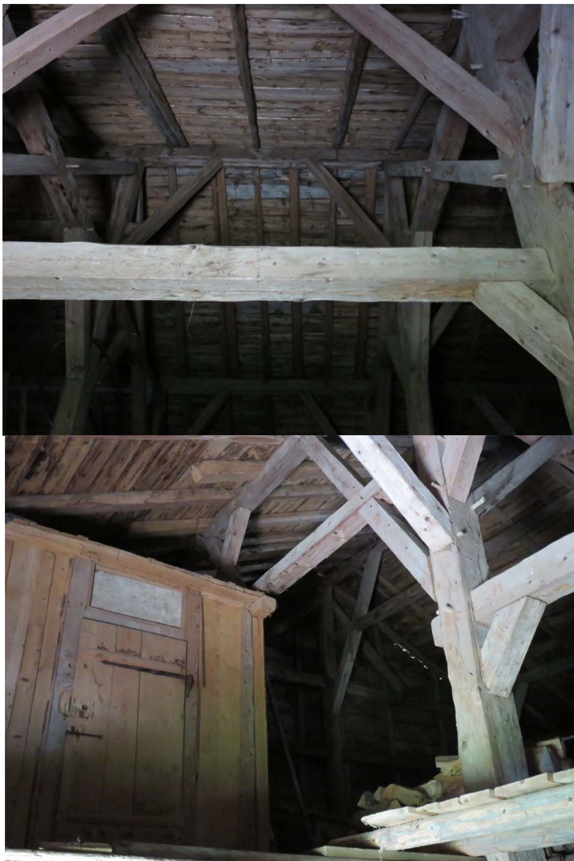
Une très belle poutraison pour un chalet méconnu, parce que fort éloigné de la route principale Charbonnières-Mouthe.
